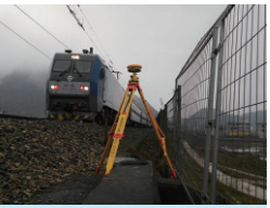
渝怀铁路复线建设CP II复测
