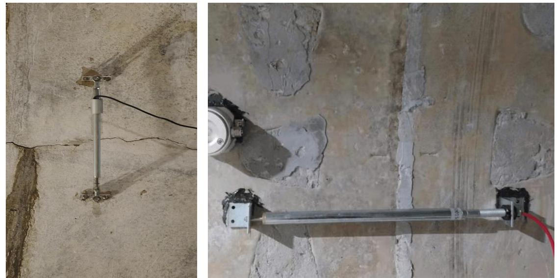
安装在测缝两侧
