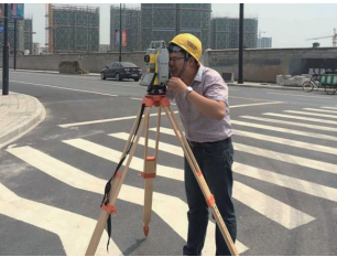
杭州市政管线测量
