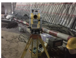
隧道施工测量
