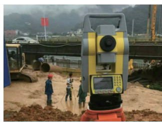
管道施工测量
