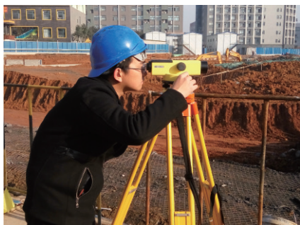
房屋建筑施工测量
