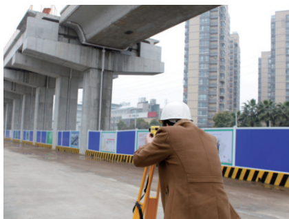
桥梁高程测量
